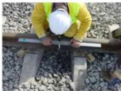
Alineación y nivelación de los extremos de los rieles a soldar
