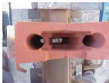
Colocación de los moldes
