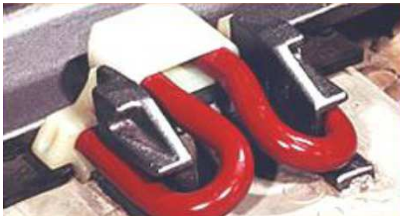
Sujeción Pandrol Fast Clip en traviesas de hormigón
