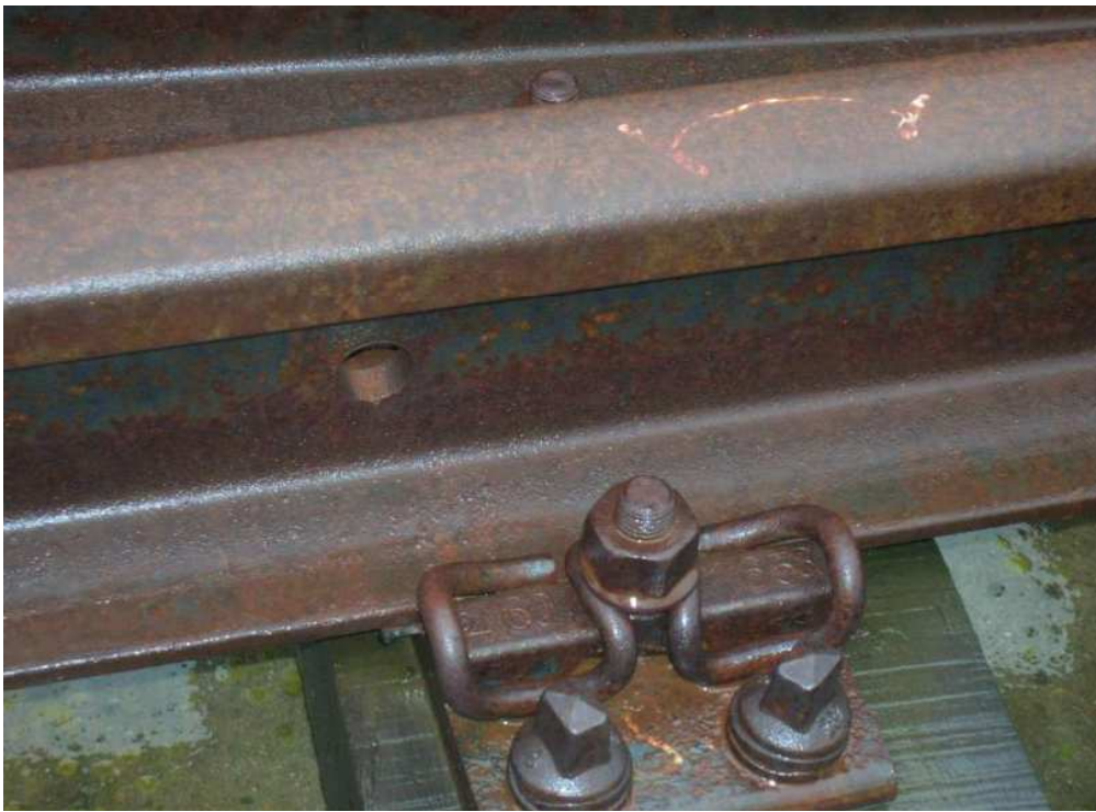
Sujeción elástica Vossloh Ski-12 en traviesa de madera
