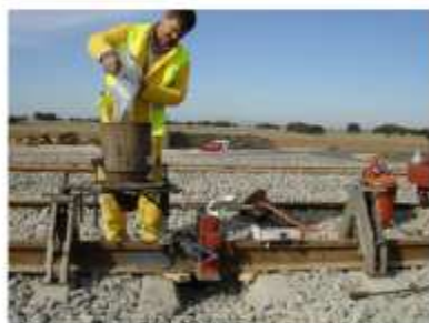
Colocación del kit dentro del crisol
