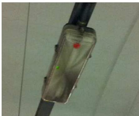
Imagen baliza autónoma de alumbrado de emergencia
