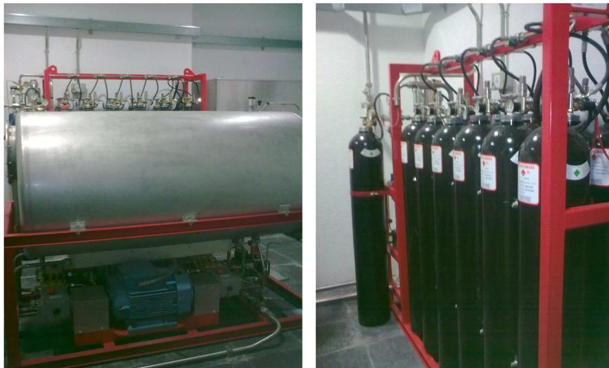
Imagen central de presión y bombeo sistema de agua nebulizada
