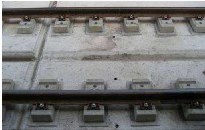
**Vía en placa o vía sobre placa de hormigón**
