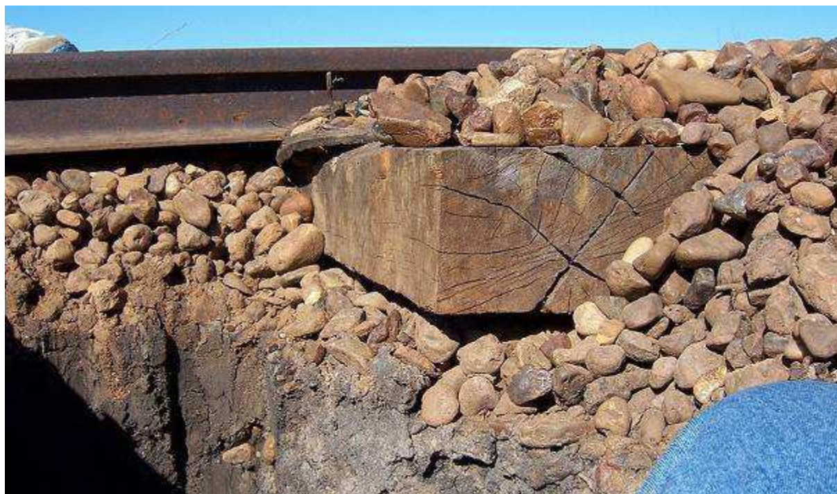
Plataforma de piedra con vía sobre traviesas de madera y balasto
