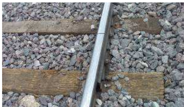
Junta y eclipsa en un carril
