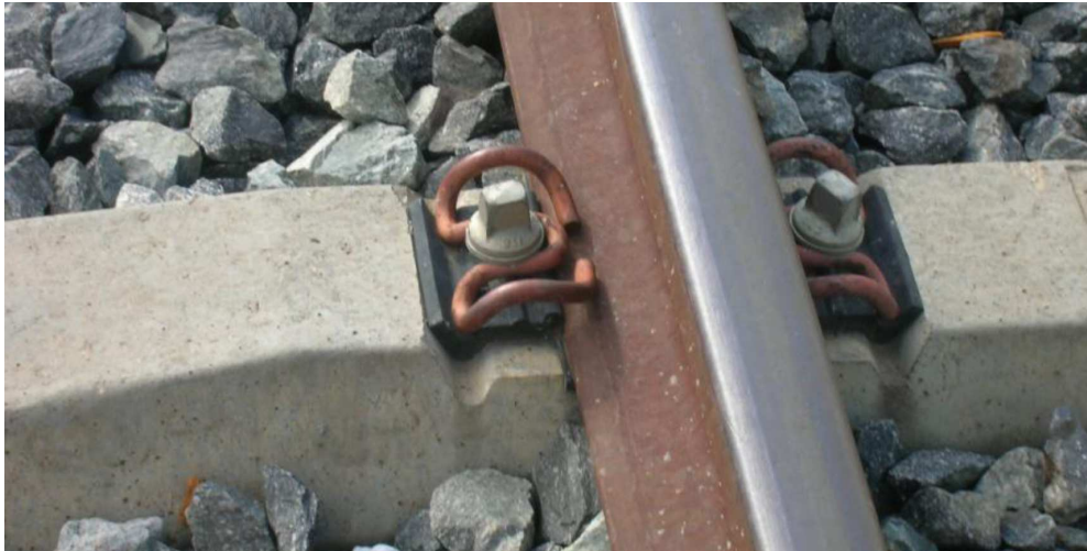
Sujeción elástica Vossloh SKI-1 en traviesa de hormigón
