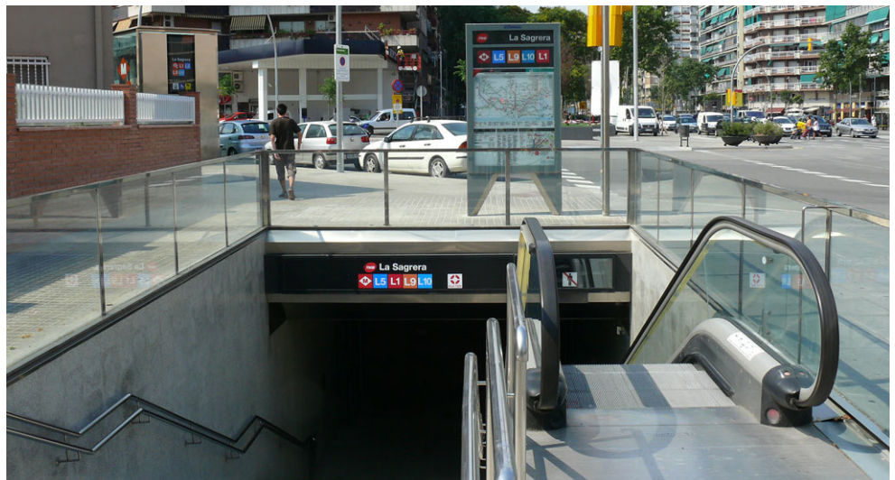
Entrada al metro
