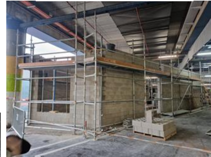
Construcció de la subestació transformadora
